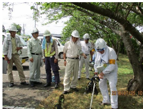
草刈現場(七尾市八幡町の食品工場)
